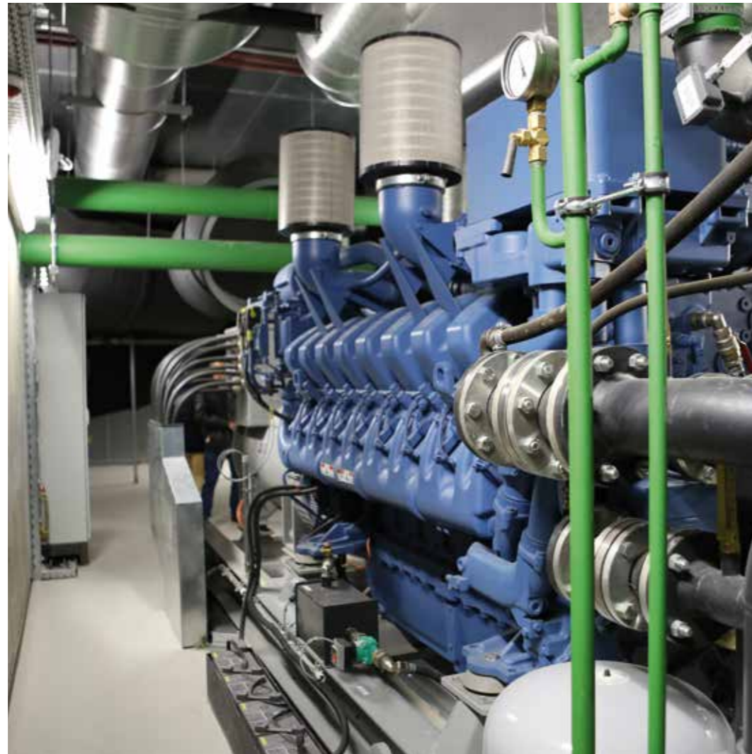
Groupe électrogène assurant l'alimentation électrique sans coupure
