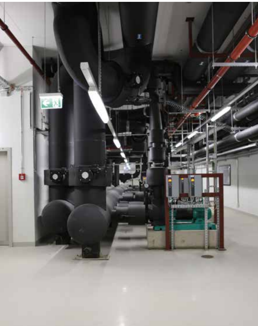
Collecteur principal de distribution d'eau glacée
