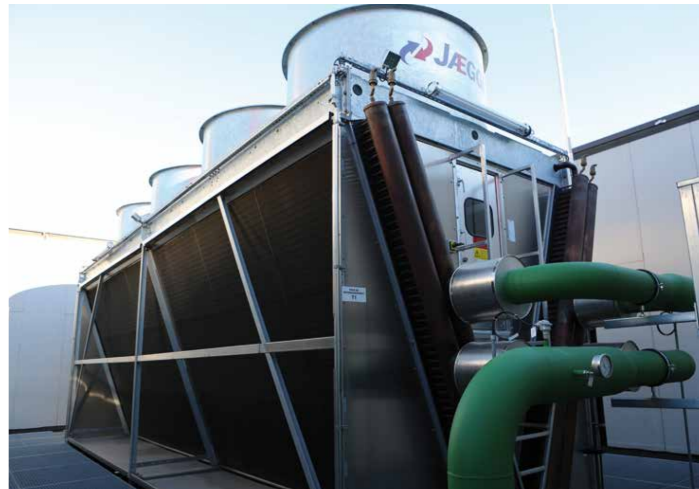
Tours de refroidissement sur la toiture de la Maison du Nombre
