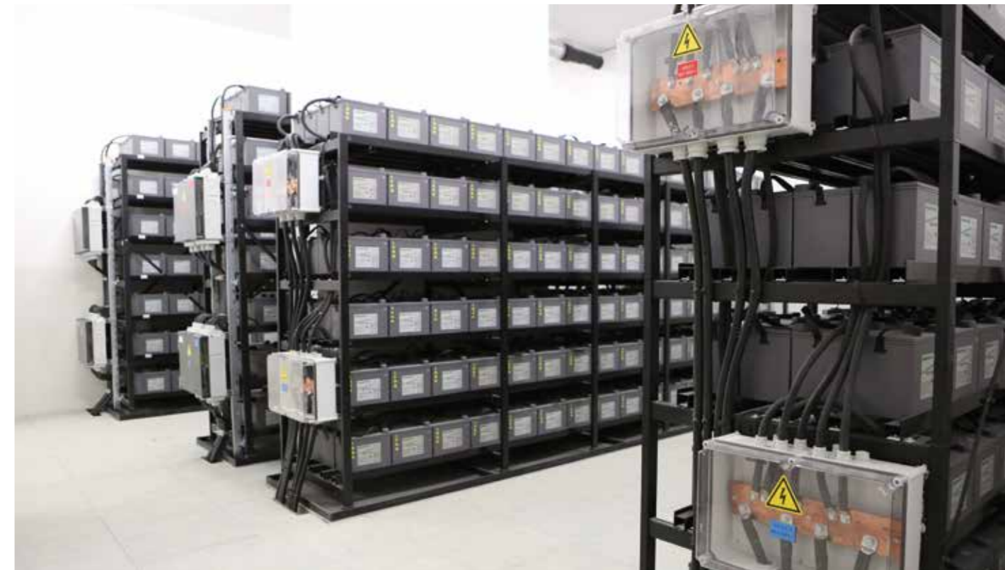
Racks de batteries des unités d'alimentation électrique sans coupure (UPS)
