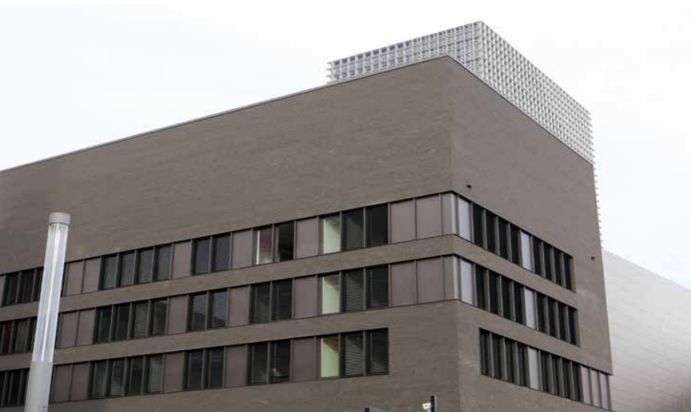
La façade de la Maison du Nombre du côté Sud-Est
